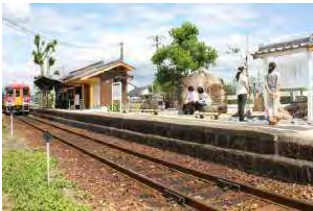
駅舎とプラットフォーム（大正7年建築）
