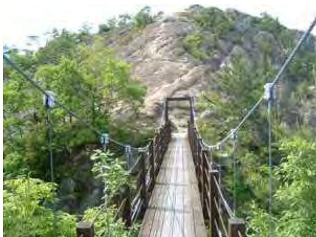
笠松山と善防山を結ぶつり橋
