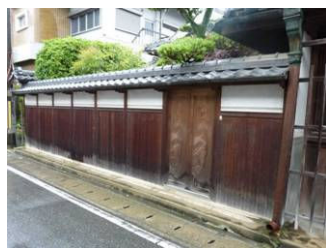
真壁瓦葺き、腰板張りの塀
