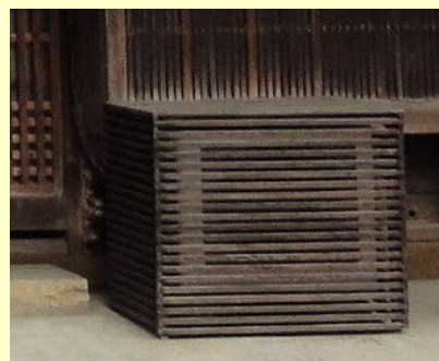
室外機を木製の枠により目隠しした例
