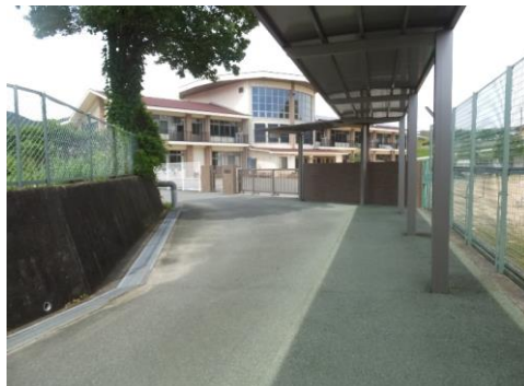
プール横通 路
