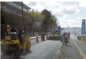
道路補修工事の様子(市道古坂高室線)
