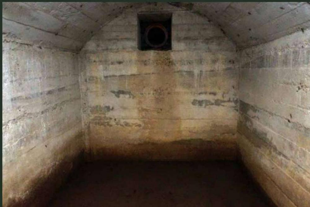
コンクリートで作られた地下構造の退避壕で深さは3m程あります。内部構造は爆風を避けるために複雑な構造になっており、換気口も設けられています。
