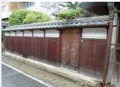
真壁瓦葺き、蕨板張りの塀
