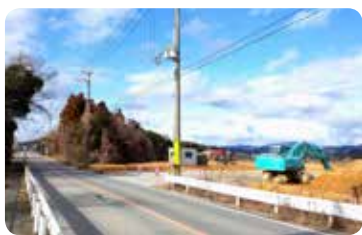
県道三木穴栗線と鶉野飛行場線の接続部分の工事の様子。 (令和5年1月16日撮影)
