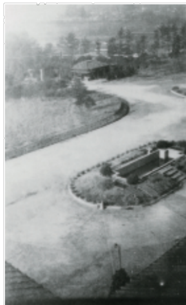
写真5 兵舎から見た衛兵詰所
