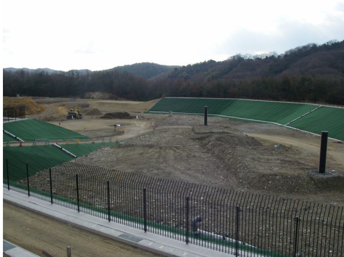
加西市最終処分場
