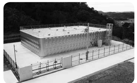
県水を供給する鴨谷配水池
