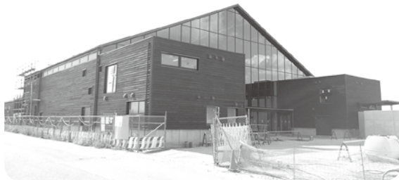
建設が進む『sora kasai』
