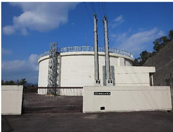
明神山配水池
