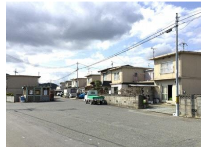
【公営住宅】 No.14
