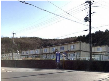
名称 北条 建築年月 1978/04 建築延床面積 3,525.60 m 2
