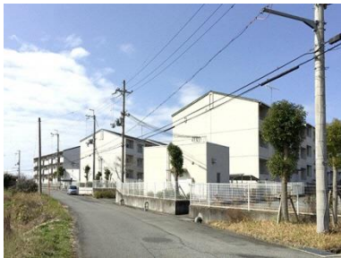
【公営住宅】 No.06
