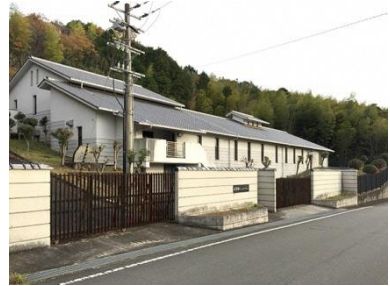
名称 日吉西コミュニティプラント 建築年月 1995/09 建築延床面積 457.91 m 2
