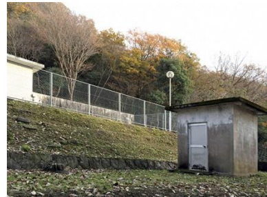
名称 古坂第1配水池 建築年月 1968 建築延床面積 10.20 m 2
