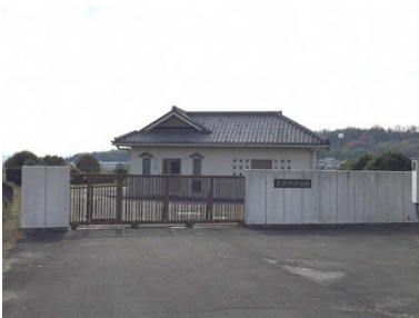
名称 玉野地区処理施設 建築年月 1999/03 建築延床面積 97.10 m 2
