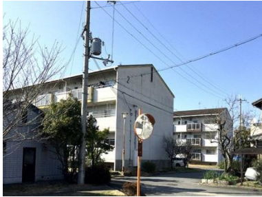
【公営住宅】 No. 03
