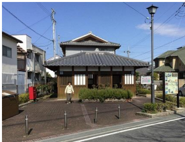
名称 南町公衆便所 建築年月 1996/03 建築延床面積 28.35 ㎡
