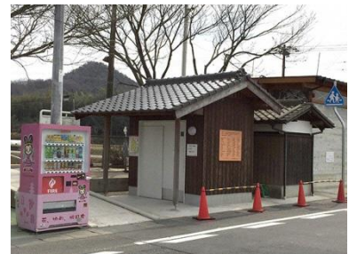
名称 播磨横田駅公衆便所 建築年月 2013/12 建築延床面積 4.96 m 2
