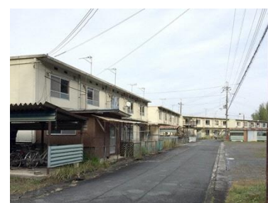
【公営住宅】 No. 01
