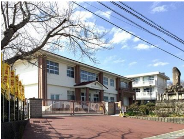
名称 富田小学校 建築年月 - 建築延床面積 3,835.00 m 2
