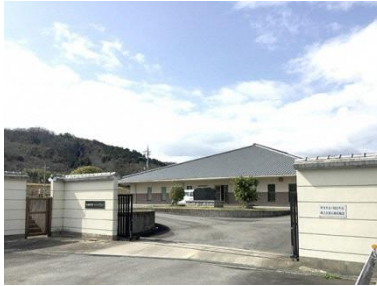
名称 加西北部コミュニティプラント 建築年月 2001/03 建築延床面積 870.51 m 2
