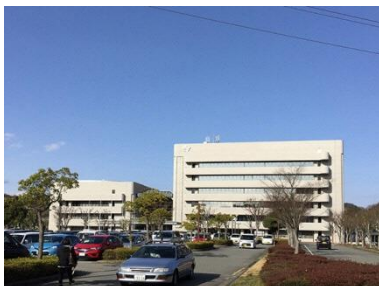
名称 庁舎 建築年月 1989/11 建築延床面積 12,171.60 m 2
