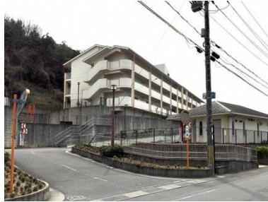
【公営住宅】 No. 04
