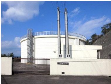
名称 明神山配水池 建築年月 1998 建築延床面積 36.00 m 2
