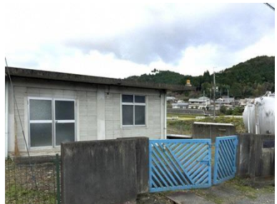
名称 瀬加加圧ポンプ場 建築年月 1968 建築延床面積 96.00 m 2
