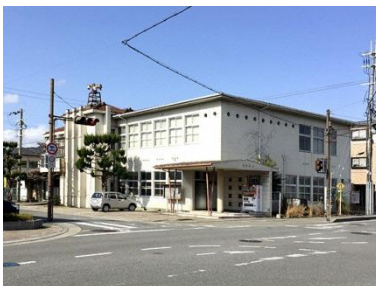
名称 旧本庁舎 建築年月 1950/01 建築延床面積 1,309.91 m 2
