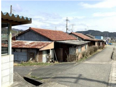
【公営住宅】 No.09
