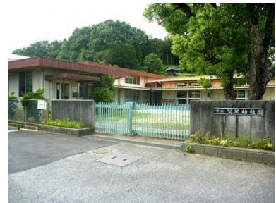
名称 賀茂学童保育園 建築年月 1981/03 建築延床面積 343.00 m 2
