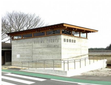
名称 播磨横田駅駅舎 建築年月 2015/01 建築延床面積 38.88 m 2
