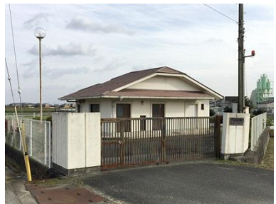
名称 岸呂処理施設 建築年月 1992/08 建築延床面積 94.89 m 2
