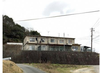
名称 東野田 建築年月 1975/03 建築延床面積 992.20 m 2
