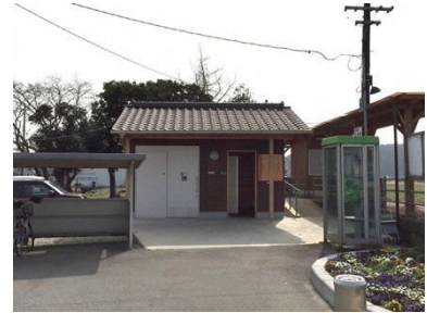
名称 田原駅公衆便所 建築年月 2012/12 建築延床面積 9.85 ㎡
