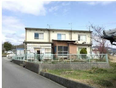
【公営住宅】 No.13
