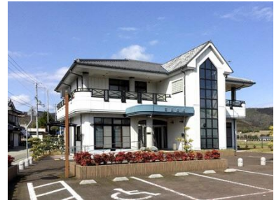
名称 富田コミュニティ施設 建築年月 2000/12 建築延床面積 320.00㎡
