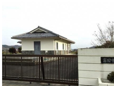
名称 富田中処理施設 建築年月 2000/03 建築延床面積 154.23 m 2
