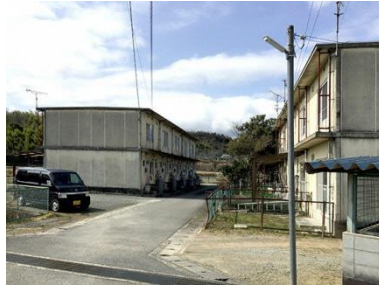
【公営住宅】 No.10
