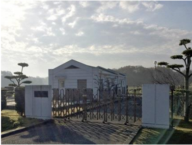
名称 別府中処理施設 建築年月 1993/11 建築延床面積 269.46 m 2
