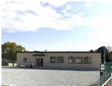
名称 北条学童保育園 建築年月 2014/03 建築延床面積 192.72 m 2
