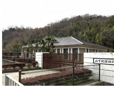
名称 山下地区処理施設 建築年月 1995/04 建築延床面積 248.67 m 2
