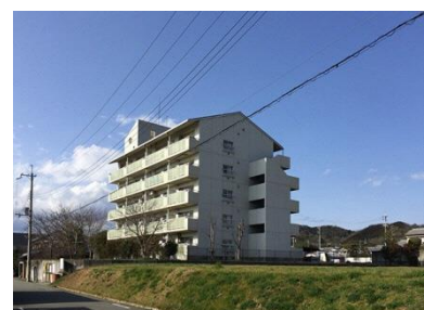
【公営住宅】 No. 02
