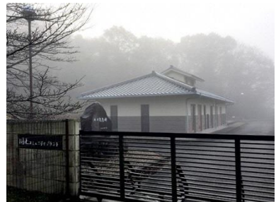
名称 国正地区コミュニティプラント 建築年月 1998/04 建築延床面積 187.97 m 2
