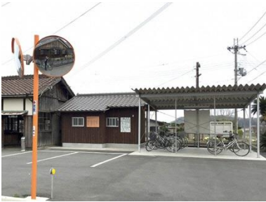
名称 長駅公衆便所 建築年月 2013/12 建築延床面積 9.85 ㎡
