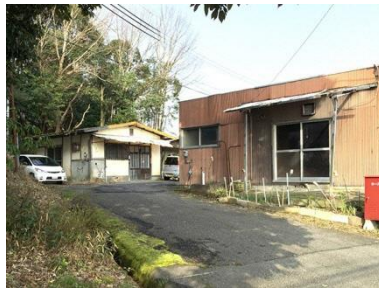
【公営住宅】 No.07
