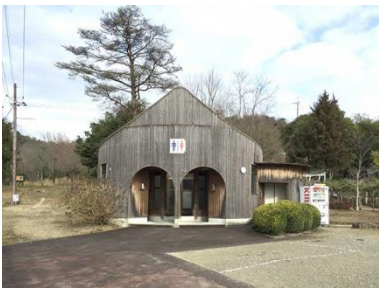
名称 体育センター公衆便所 建築年月 1994/04 建築延床面積 64.20 ㎡
