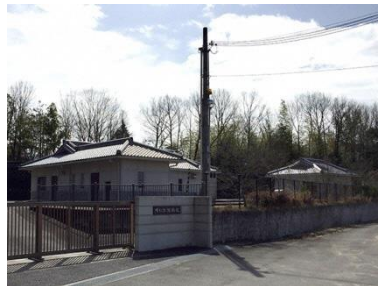
名称 宇仁地区処理施設 建築年月 2003/07 建築延床面積 231.00 m 2
