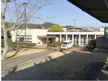
名称 埋蔵文化財整理室 建築年月 1983/03 建築延床面積 622.00㎡
