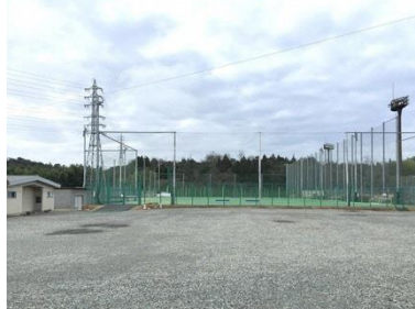
名称 多目的グラウンド 建築年月 2014/03 建築延床面積 28.33㎡
