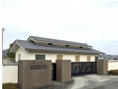
名称 鴨谷地区処理施設 建築年月 1997/04 建築延床面積 92.55 m 2
