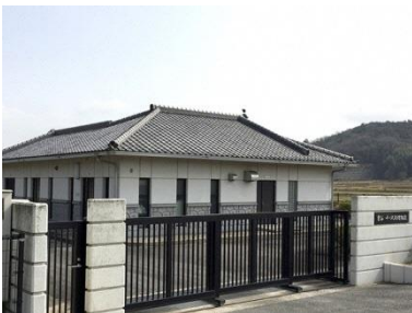
名称 倉谷・千ノ沢処理施設 建築年月 2001/03 建築延床面積 138.50 m 2
