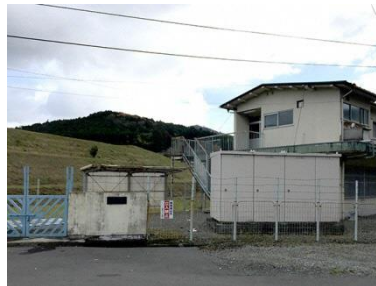
名称 瀬加送水ポンプ場 建築年月 1968 建築延床面積 71.50 m 2
