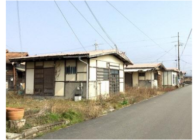
【公営住宅】 No. 05
