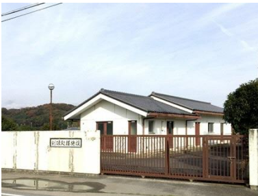
名称 剣坂地区処理施設 建築年月 1997/04 建築延床面積 100.58 m 2
