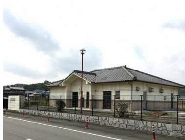
名称 横田処理施設 建築年月 2001/03 建築延床面積 144.80 m 2
