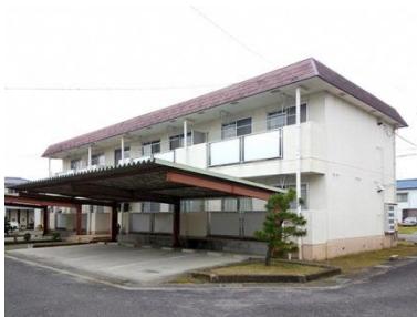
名称 加西病院第2啓心寮 建築年月 1984/03 建築延床面積 330.00 m 2
